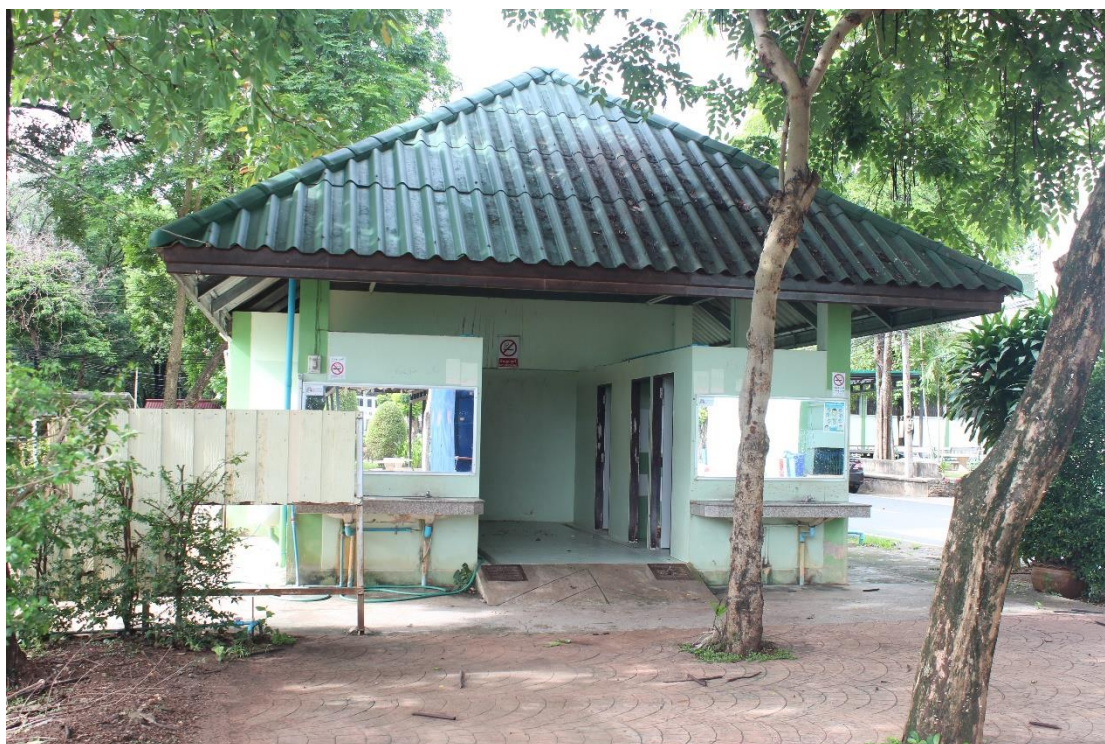
ห้องน้ำ-ห้องส้วม
